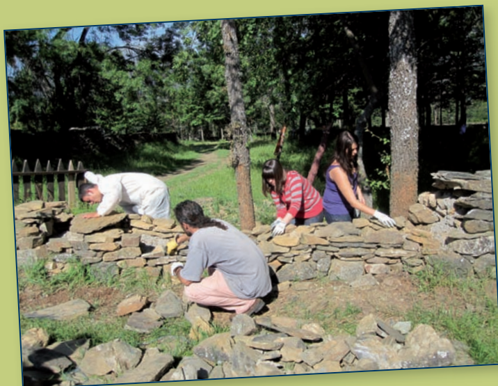
Reconstrucción de muro.
